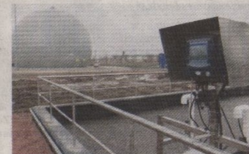
Nowoczesne urządzenia pomiarowe przy reaktorze biologicznym
