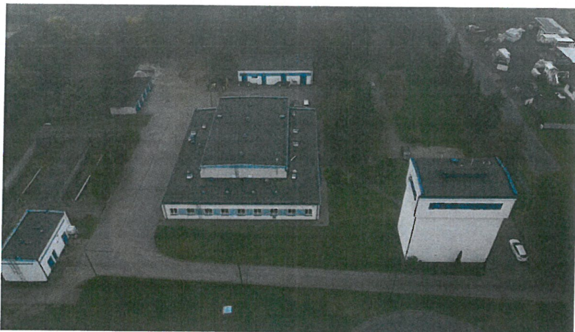
Zdjęcie 2 Widok ogólny budynku
